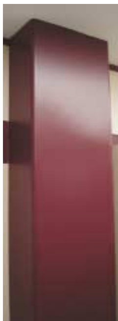
Revestimiento de columna con MAX Compactforming Tipo: U, de 6 mm de espesor con rastrel y adhesivo poliuretánico, tipo SIKA o similar.
