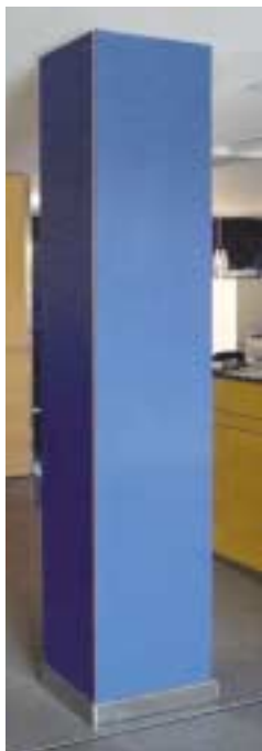
Revestimiento de columna con MAX Compacto de 6 mm de espesor, con rastrel y adhesivo poliuretánico, tipo SIKA o similar.
