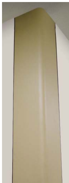
Detalle de esquina exterior con FUNDERMAX Compactforming Tipo: L, de 6 mm de espesor y fijado con rastrel y adhesivo poliuretánico, tipo SIKA o similar.
