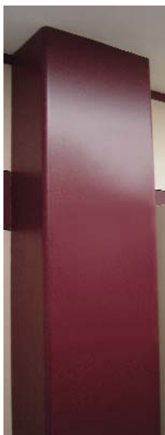
Revestimiento de columna con FUNDERMAX Compactforming Tipo: U, de 6 mm de espesor con rastrel y adhesivo poliuretánico, tipo SIKA o similar.
