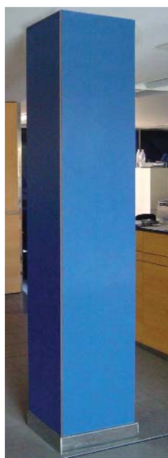
Revestimiento de columna con FUNDERMAX Compacto de 6 mm de espesor, con rastrel y adhesivo poliuretánico, tipo SIKA o similar.
