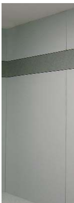
Detalle de unión entre dos paneles de FUNDERMAX Compacto de 6 mm de espesor con rastrel y adhesivo poliuretánico, tipo SIKA o similar.
